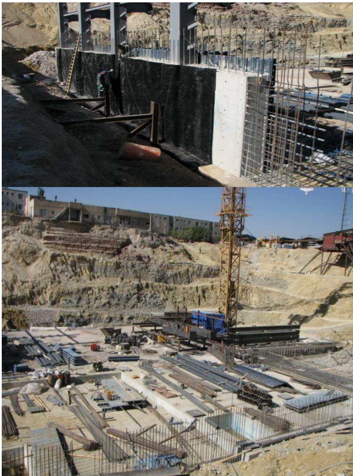
اجرای عملیات ستون گذاری و اجرای دیوارهای حائل
